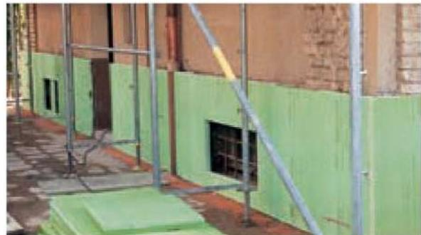
**Fig. 18:** Aislamiento adicional del zócalo con Styrodur® 2800 C.
