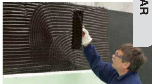
Fig. 12: PCI Pecimor® DK es un pegamento de planchas de aislamiento especialmente apto para su aplicación en aislamiento perimetral.
