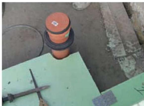
Fig. 22: Styrodur se puede trabajar fácilmente y se adapta de manera idónea a las circunstancias de la obra.
