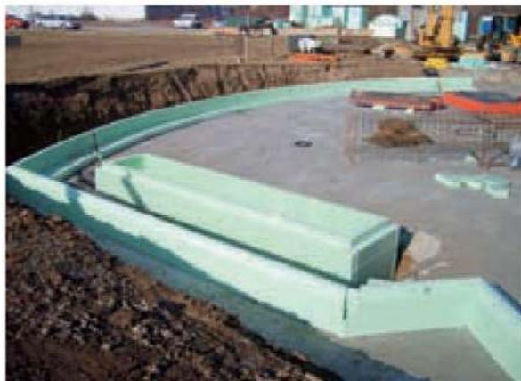
Fig. 19: Construcción del encofrado Styrodur® C.
