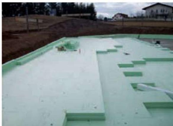
Fig. 20: Aplicación de más de una capa de Styrodur C bajo la losa de cimentación.
