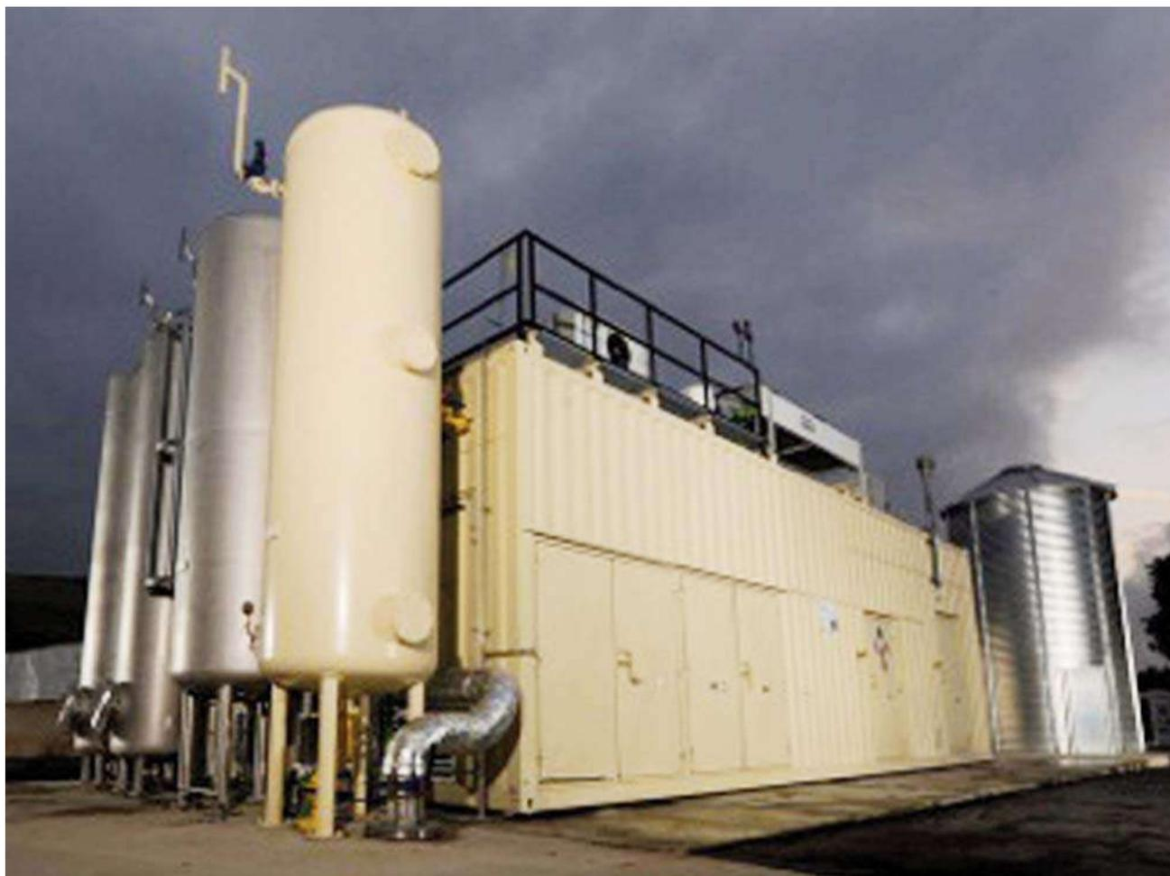
La planta de depuración de biogás de la empresa Erdgas Südwest GmbH produce e inyecta biometano en la red de gas natural desde marzo de 2012. El biogás procede de la planta de Laupheim, 30 km al sur de Ulm, Alemania, que desde 2008 genera biogás a partir de restos de maíz y paja ensilada. La planta de depuración procesa 600 m<sup>3</sup>/hora de biogás, suficiente como para suministrar energía eléctrica a 2.000 viviendas.
