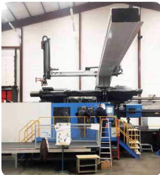
• Robot WITTMANN WX193, el primero de su tipo, durante los trabajos de instalación en abril de 2019.
