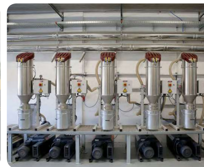
• Sistema de transporte central WITTMANN (Foto: Wittmann Battenfeld Rumanía)
