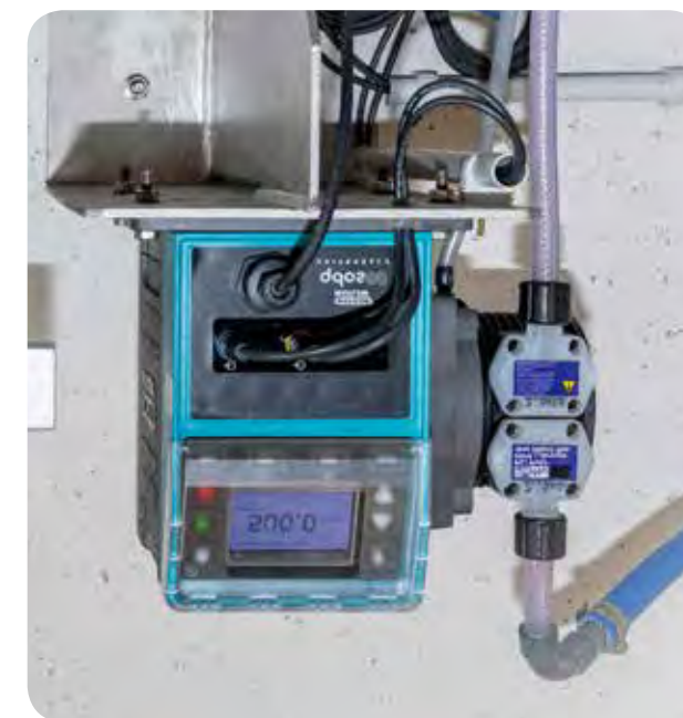
1 & 2: La nueva Qdos 60 PU posee un cabezal con elemento de manguera de poliuretano. El proceso de dosificación se regula mediante un sistema de control externo.
