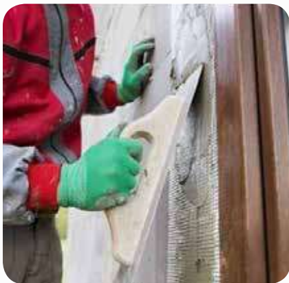
Aplicación de mortero anticorrosivo
