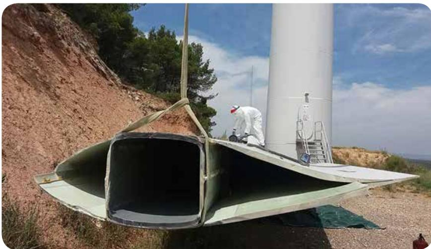
Para transportar la pala de forma eficiente fue necesario segmentar la pala en secciones. Durante este proceso se llevaron a cabo las actuaciones necesarias para la minimización de la propagación del polvo producido durante
