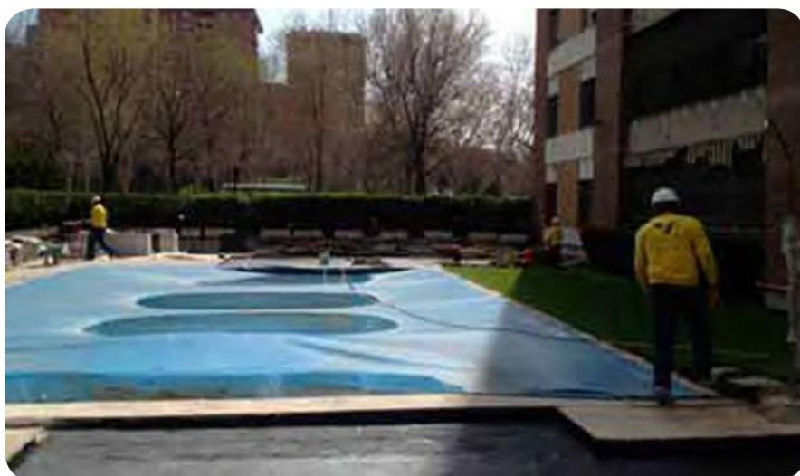
no quiere decir esto que lo podamos aplicar sobre soportes encharcados o que sobre los mismos acabe de llover. Para poder realizar la aplicación en estas condiciones, es necesario colocar primero una imprimación epoxídica W (resistente a la humedad) y después ir aplicando manos de pintura especial para impermeabilizaciones.
